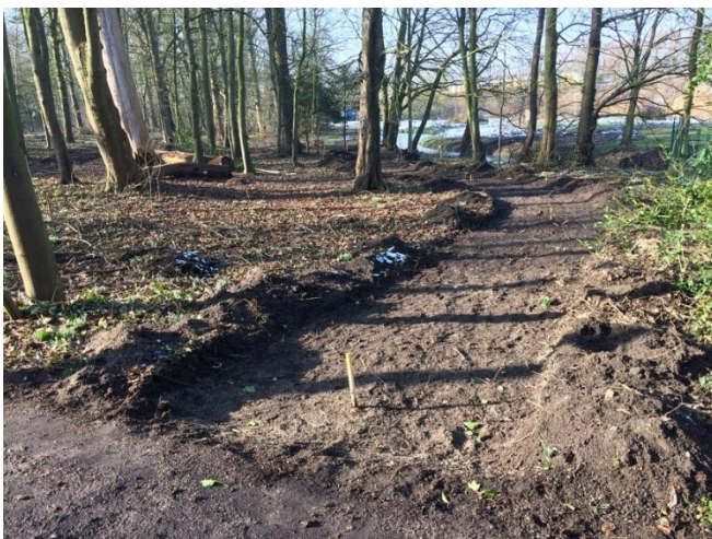
Herstelwerkzaamheden 2016/2017 (Bron: publicatie Ter Wadding, 2018)
